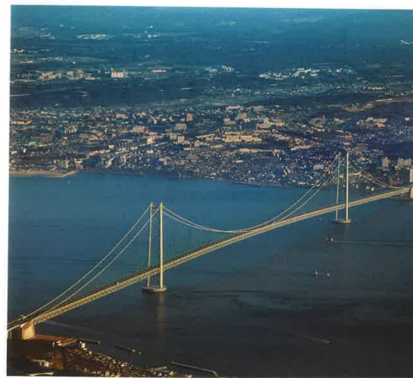
明石海峡大橋
