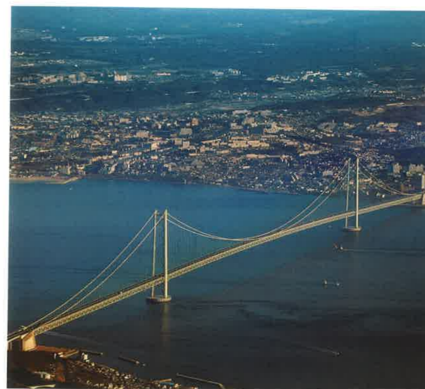
明石海峡大橋
